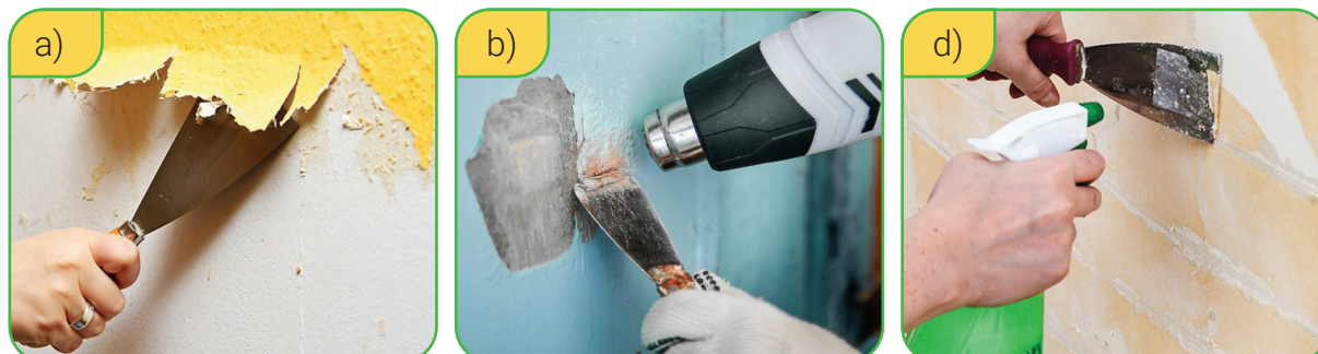
82-rasm. Qoplamalarni tozalash usullari: a) mexanik usul; b) termik usul; d) kimyoviy usul.
